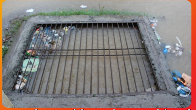
ड्रम नालीतून 'फार्म पिट' मध्ये जमा झालेले पाणी
